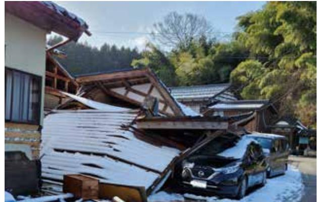
図3 倒壊した家屋に押しつぶされた自動車
