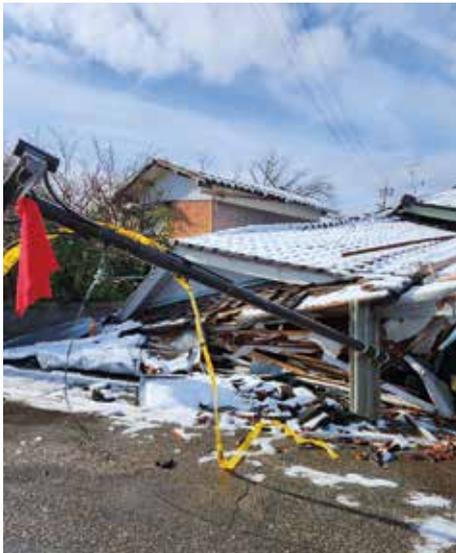
図4 倒壊した電柱と家屋
